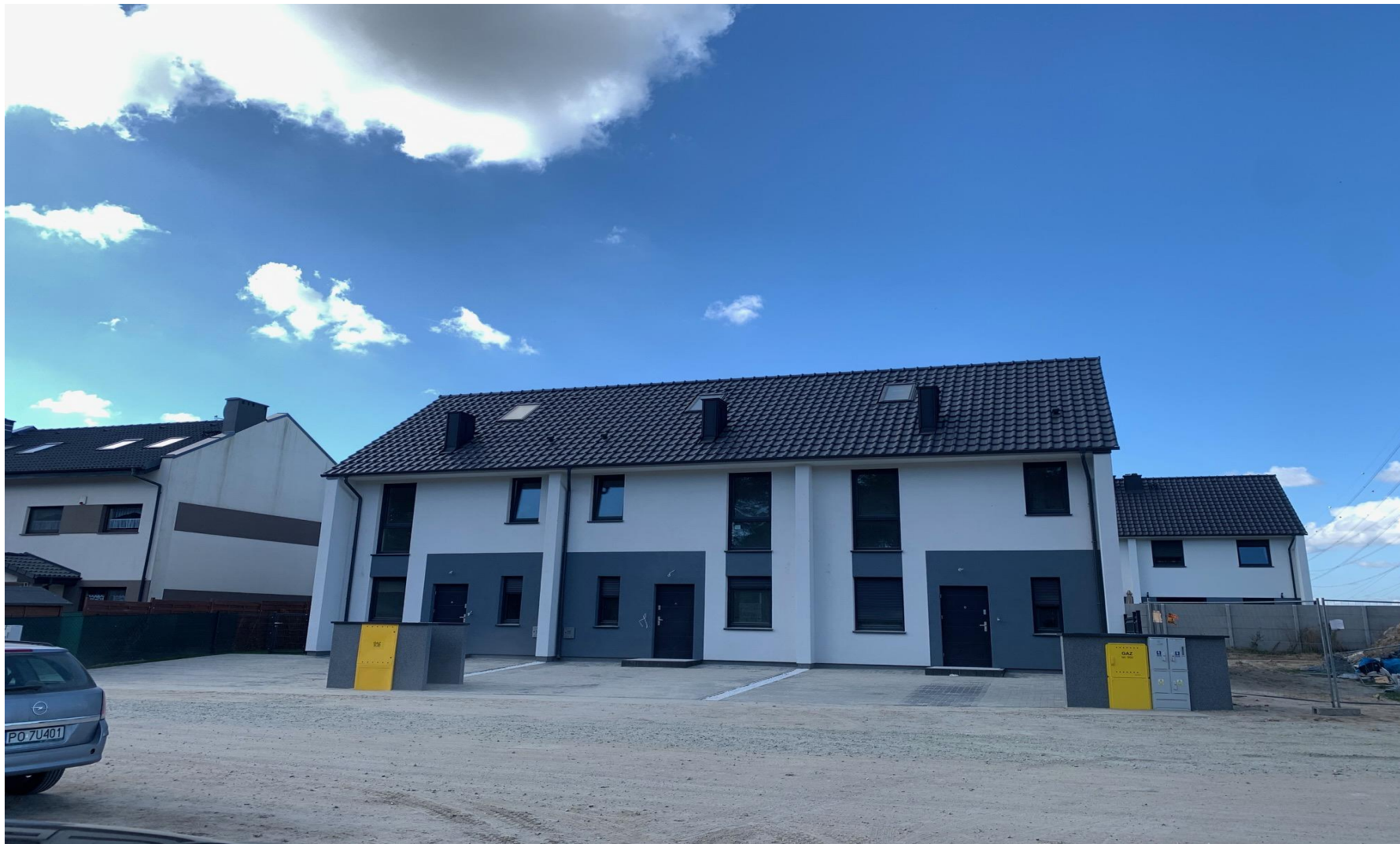
Kameralne 3 domy w zabudowie szeregowej, z bezpośrednim widokiem na las
